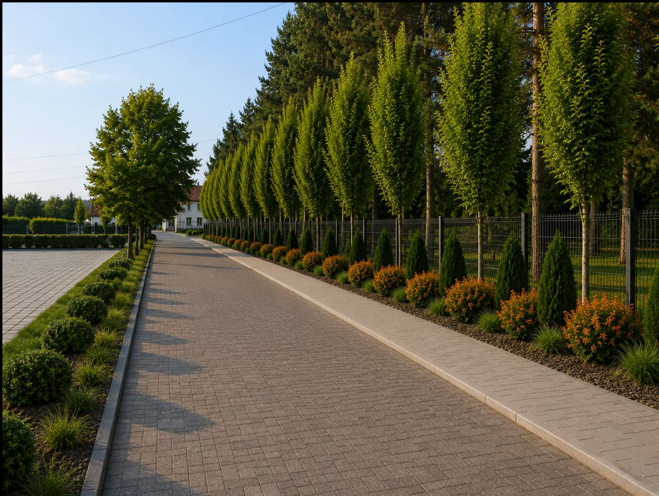
Lewy pas zieleni i ciąg komunikacyjny - po przebudowie
